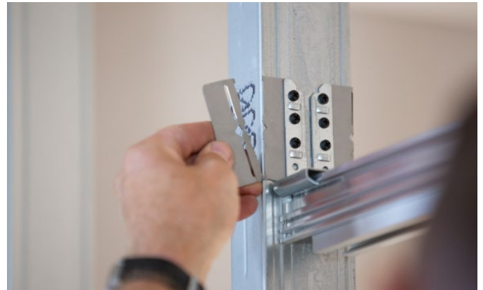
Bild 27: Sicherungslaschen entfernen
