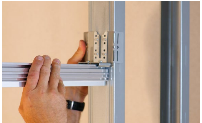
Bild 20: Sicherungslaschen umklappen
