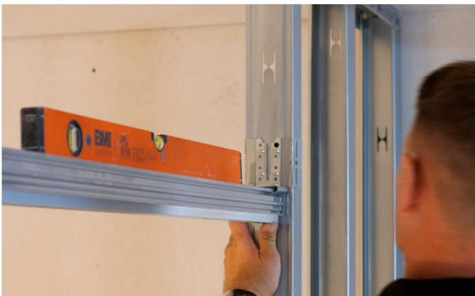
Bild 24: Ausrichtung Tragschiene
