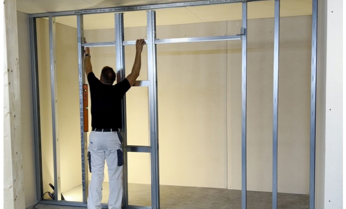
Bild 19: Ausrichten Pocket Kit Easy
