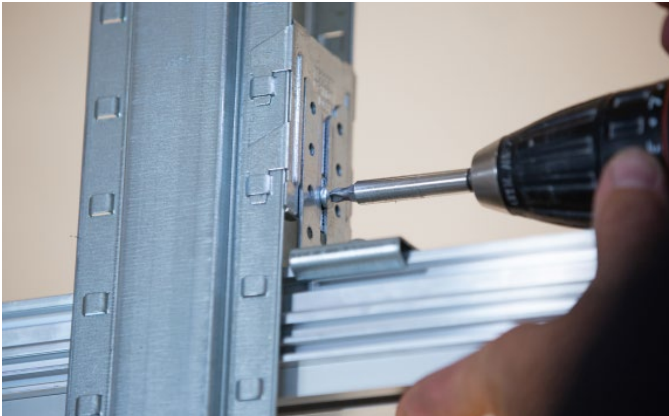
Bild 23: Aufhängung Tragschiene justieren
