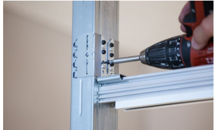
Bild 26: Verschraubung
