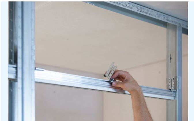
Bild 29: Unterkonstruktion Wand einsetzen
