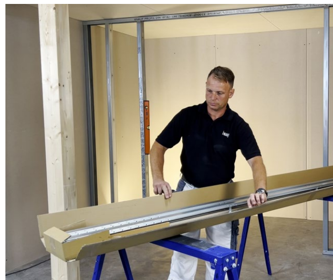
Bild 3: Teilmontierte Pocket Kit Easy
