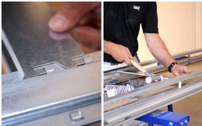
Bild 6: Tasche vormontieren
