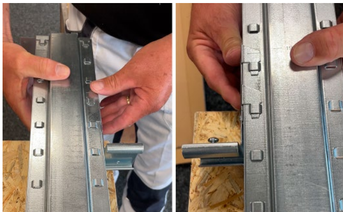
Bild 7: Distanzstück montieren
