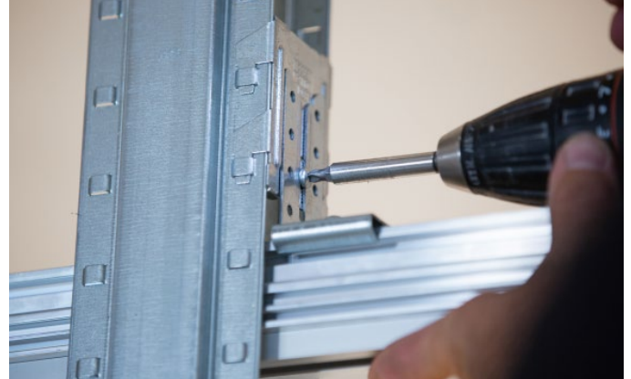
Bild 25: Aufhängung Tragschiene fixieren
